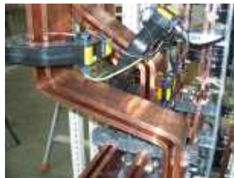
Vue d'ensemble, détail TGBT et gaine à barres 2500A
