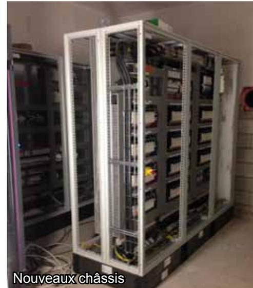
ments et essais dans l'existant ont représenté plusieurs milliers d'heures de travail et près de 30 armoires et coffrets déportés ont été remplacés à l'extrusion, la réception, la fabrication, au dosage, au stockage, à la granulation et l'ensachage.
