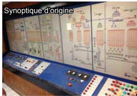
pour valoriser les graines de lin et des oléoprotagineux dans la région. L'ensemble est piloté par quatre automates Premium en réseau vers quinze stations entrées/sorties distribuées dans toute l'usine au plus près des actionneurs et capteurs, ainsi que vers les nouveaux tableaux électriques.
